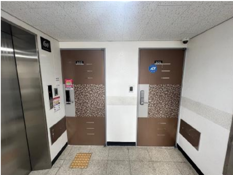
일련번호(바) 현관 전경
